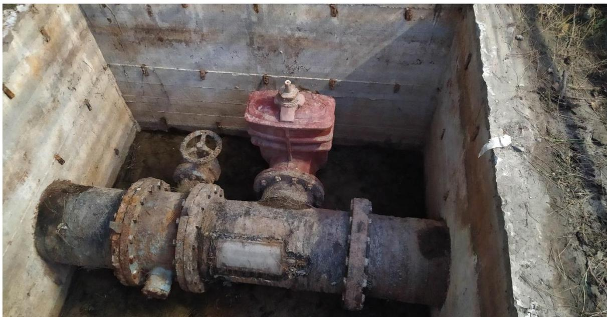
**Fig. 4** – Stato di ammaloramento nodo idraulico in uscita da sollevamento S0.
