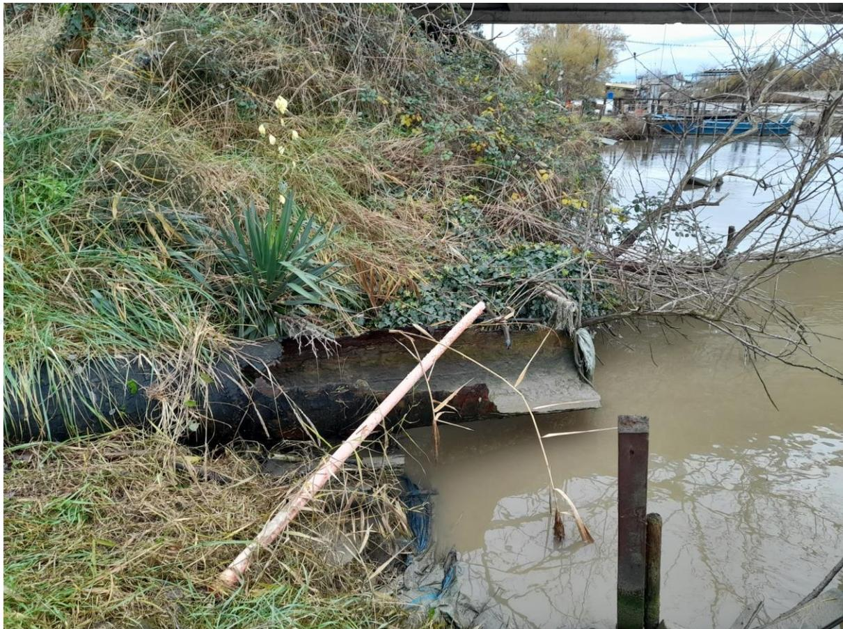
**Fig. 3** – Stato di ammaloramento condotta acque miste.
