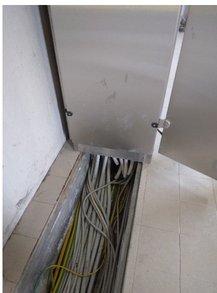
Fig. 1 – Immagini cavi tranciati cabina 1-2 collegata al suo gruppo elettrogeno
