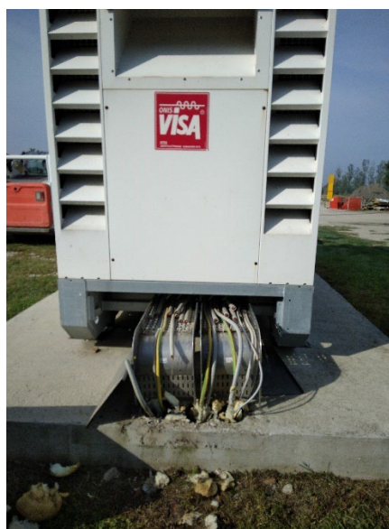
Fig. 1 – Immagini cavi tranciati cabina 1-2 collegata al suo gruppo elettrogeno
