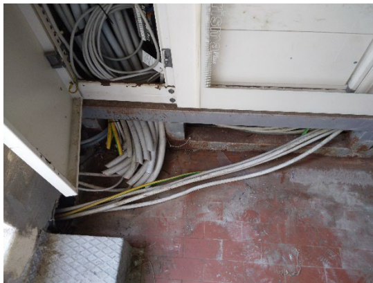
Fig. 3 – Immagini cavi tranciati cabina drenaggi collegata al suo gruppo elettrogeno
