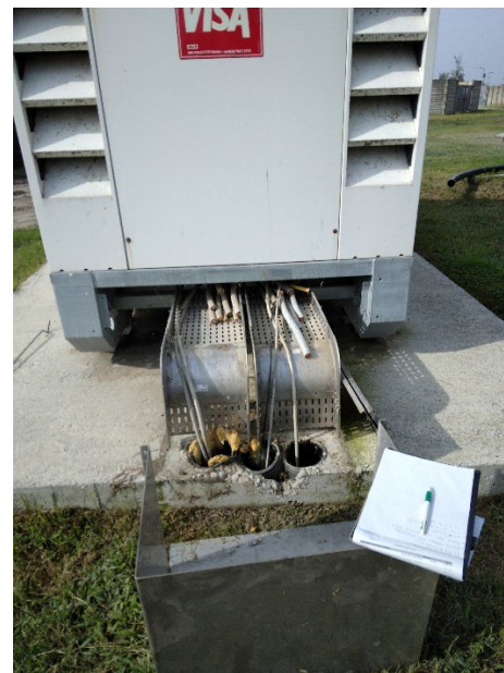
Fig. 3 – Immagini cavi tranciati cabina drenaggi collegata al suo gruppo elettrogeno
